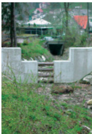
Was der Werdbach an Bäumen und grösseren Steinen mitreisst, fangen zwei Grobrechen vor dem Einlauf der Dole auf. Laut Berechnungen von Fachleuten sollte das Wasser auch dann durchfliessen können, wenn die vertikal und horizontal liegenden Pfosten mit grobem Geschiebe gefüllt sind.
