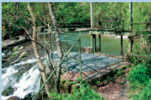
Hier zweigt der «Canal des Usiniers» von der Versoix ab. Der Wasserstand im Kanal wird von den Gewerbetreibenden mit Stauwehren reguliert.
