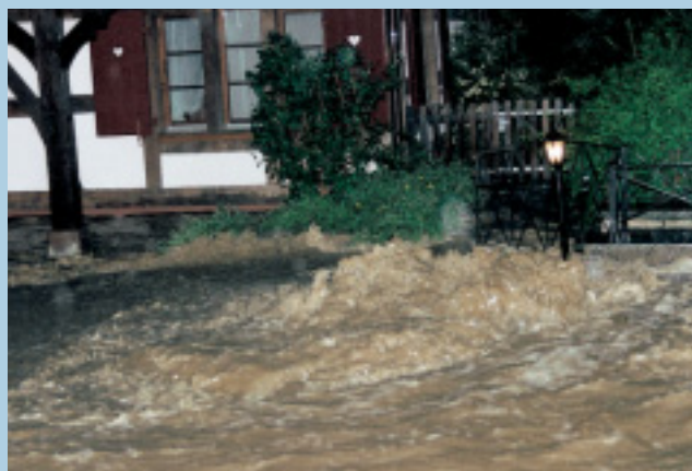
Das Haus der Familie Perret im Hochwasser.
