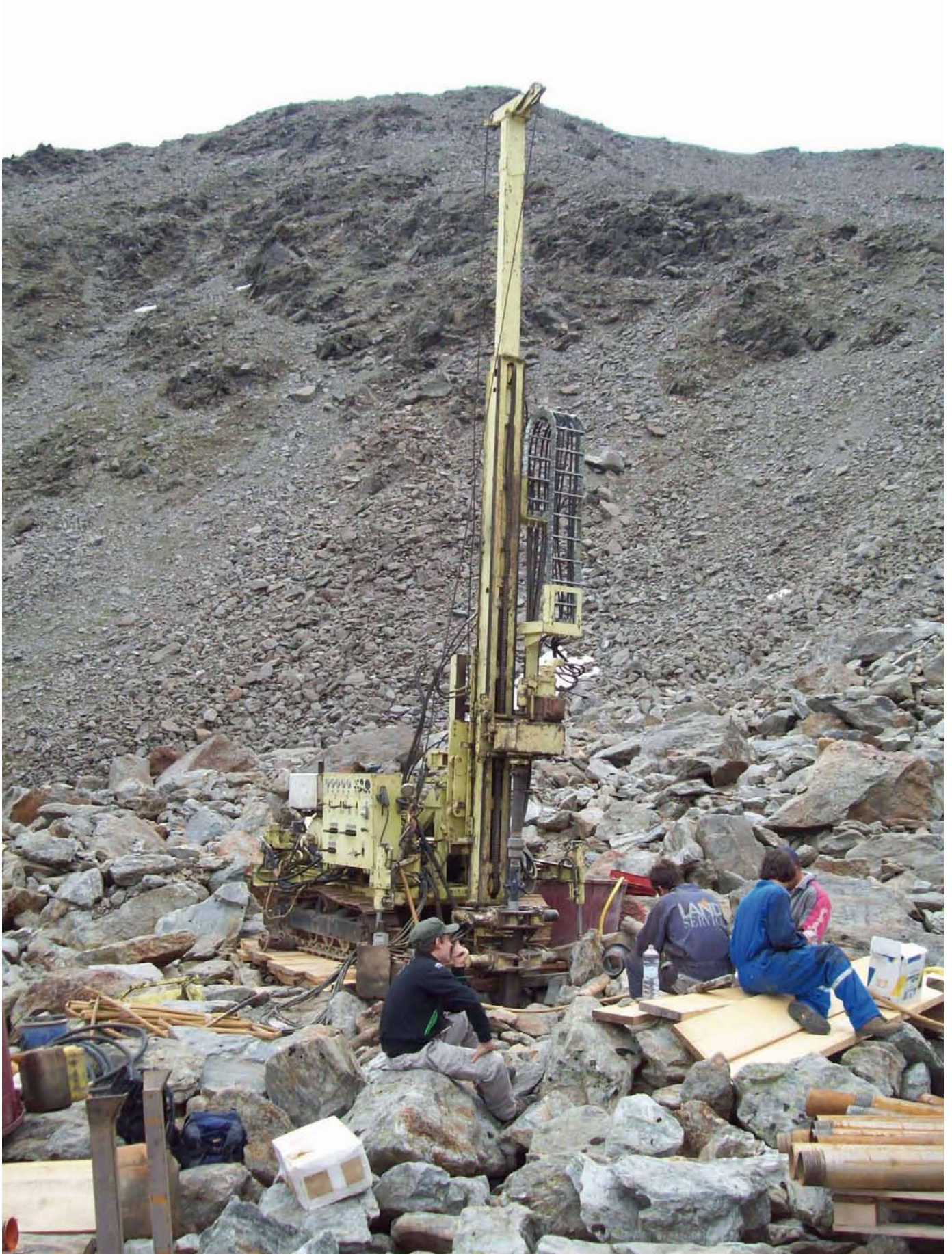
Bohrarbeiten auf einem Blockgletscher. Foto: D. Tonidandel
