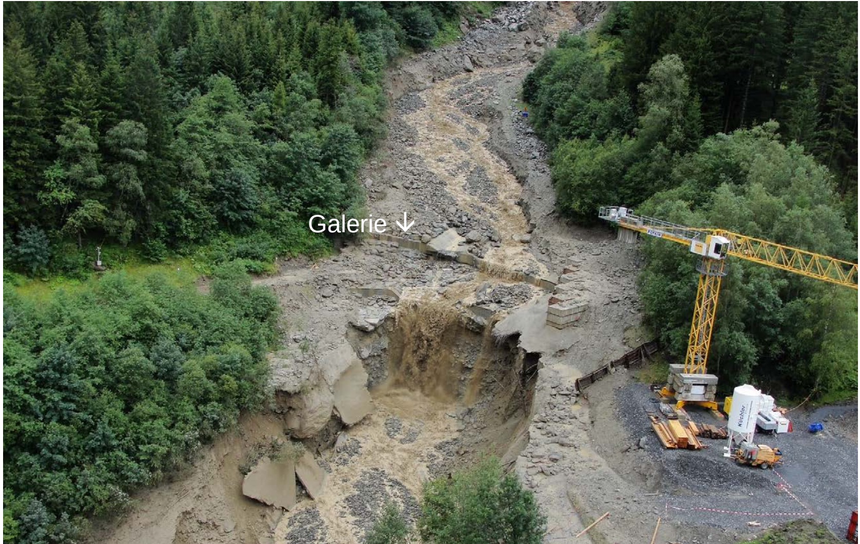
Spreitgraben im Bereich Strassengalerie nach Murgang vom 10. August 2010 Foto: Oberingenieurkreis I
